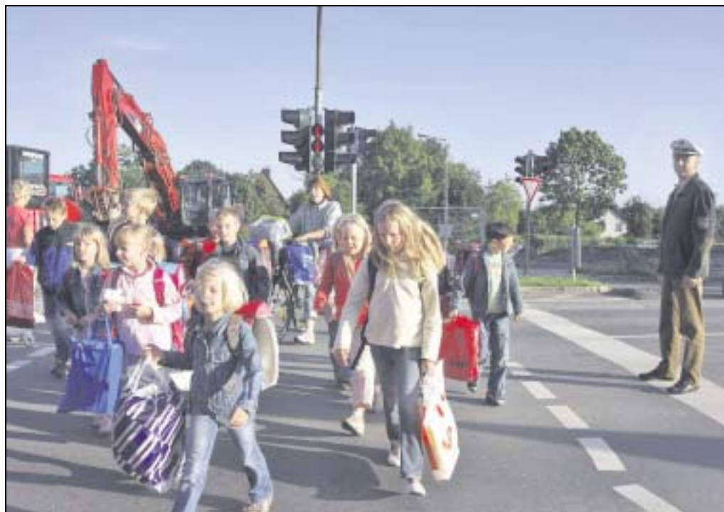
Ungefährdet können Schüler trotz Baustelle den sicheren Fußweg an der Ritterhausstraße bis zur Fußgängerampel benutzen. Ein Polizist sorgt morgens ebenfalls für Sicherheit. Foto: Derian
